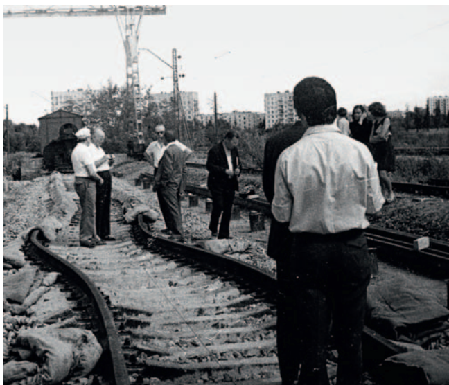
Испытания на устойчивость бесстыкового пути против выброса
