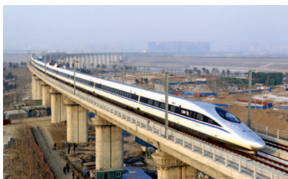
Рис. 3. Безбалластная конструкция железнодорожного пути, размещенная на эстакаде (состав CRH380A, китайские железные дороги)
