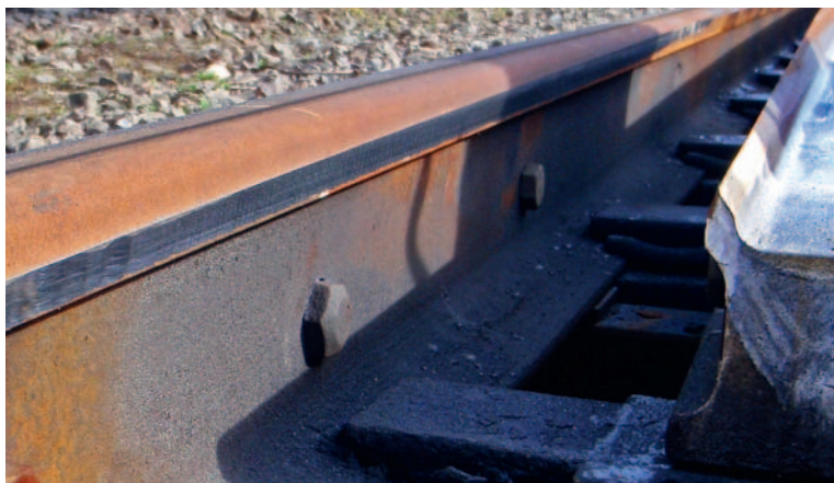
Рис. 3. Вид обработанного рамного рельса
