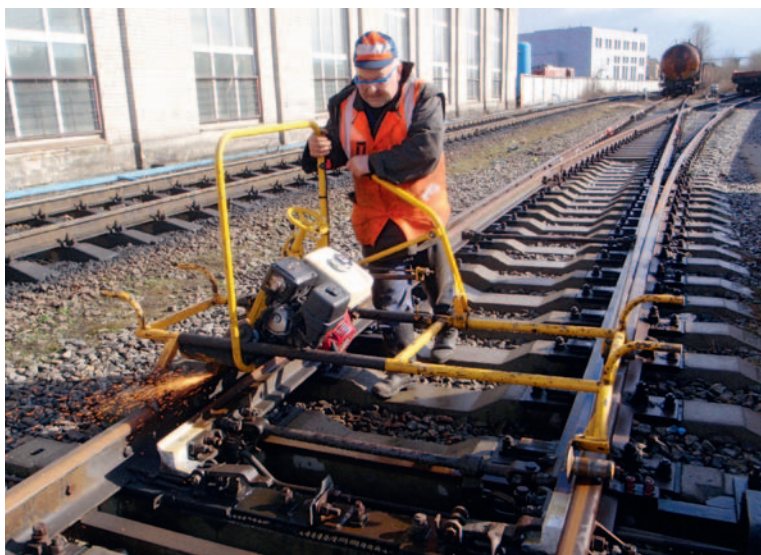
Рис. 2. Механическая обработка рамного рельса шлифовальной машиной типа MC 3 GEISMAR
