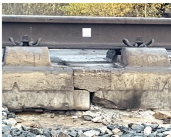
Рис. 9. Разрушение стыка плит (MaxBögl)
