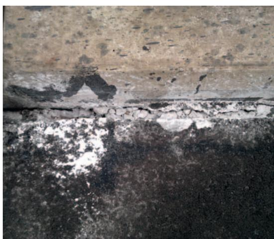
Рис. 10. Выделение цементных составляющих из-под плит (MaxBögl)
