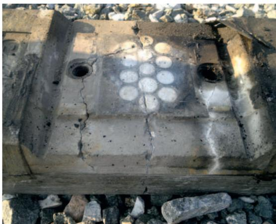
Рис. 11. Трещины бетонных блоков (LVT)
