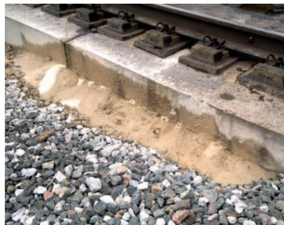
Рис. 5. Выплеск из под несущей плиты (Tines)
