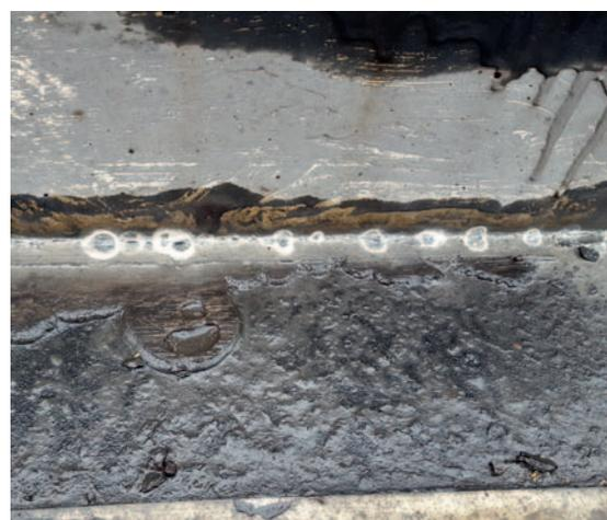
Рис. 14. Выделение цементных составляющих на стыке (LVT)
