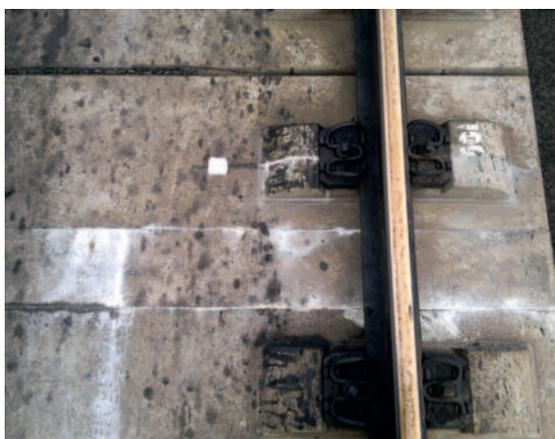
Рис. 8. Трещины на плите и на стыке плит (MaxBögl)
