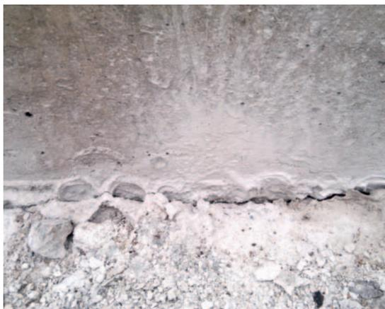
Рис. 7. Выделение цементных составляющих на стыке плит (Alstom)
