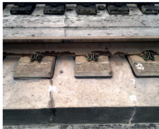
Рис. 12. Трещины путевого бетона (LVT)
