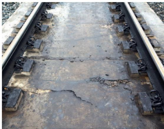
Рис. 4. Излом армированной несущей плиты по всей ширине (Tines)
