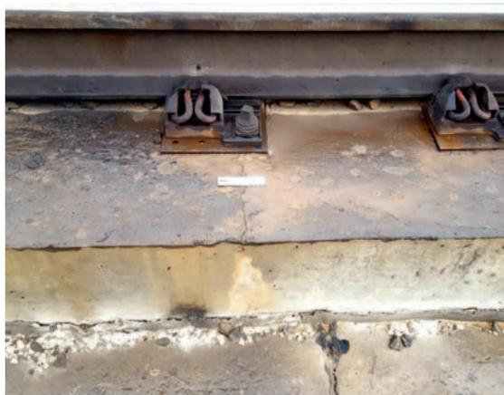
Рис. 6. Трещины в несущей плите (Alstom)
