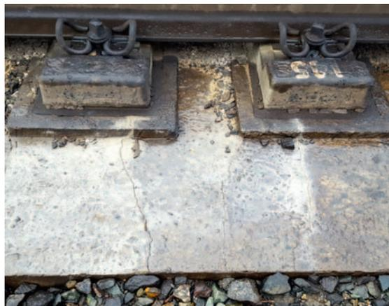
Рис. 2. Трещины в лотке блока и в несущей плите (Tines)
