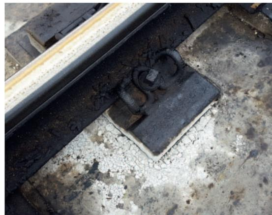
Рис. 3. Потеря сцепления блоков и несущей плиты (Tines)
