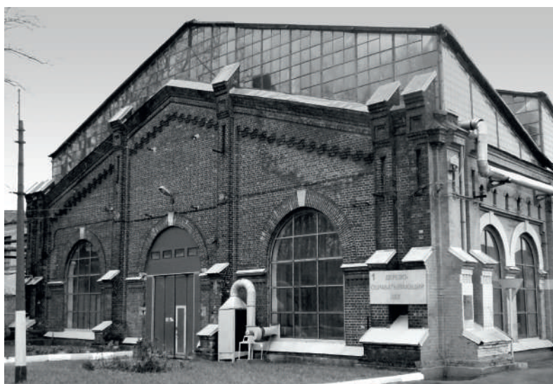
Деревообрабатывающий цех, построен в 1893-1895 годах
