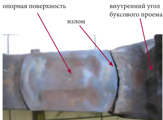
Усталостная трещина боковой рамы № 39522 (со стороны опорной поверхности буксового проема)
