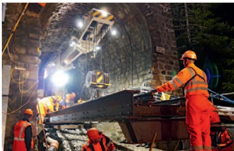
Рис. 7. Работа крана KRC с горизонтальной стрелой в тоннеле
