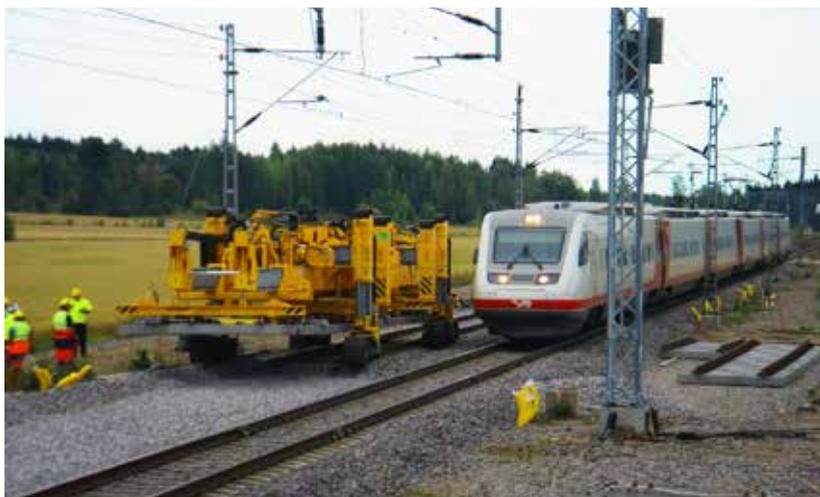
Рис. 6. Замена рельсошпальной решетки без ограничения движения поездов на соседнем пути
