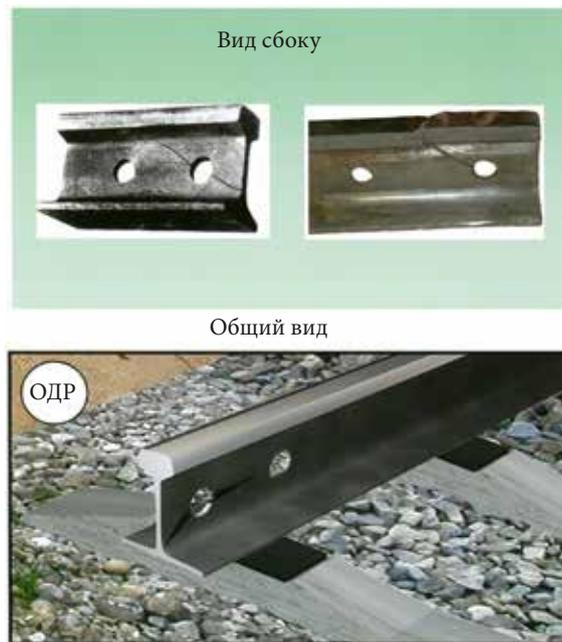
Рис. 15б. Трещина в шейке рельса. Код дефекта 53 1-2
