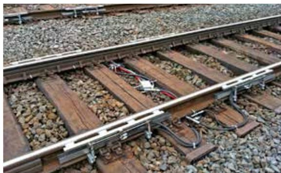
Рис. 3. Пример стационарной системы смазки для железной дороги
