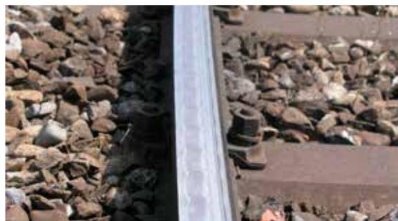
Рис. 1. Образование рифления
