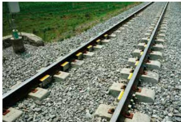
Рис. 3. Элементы напольного оборудования системы WCM
