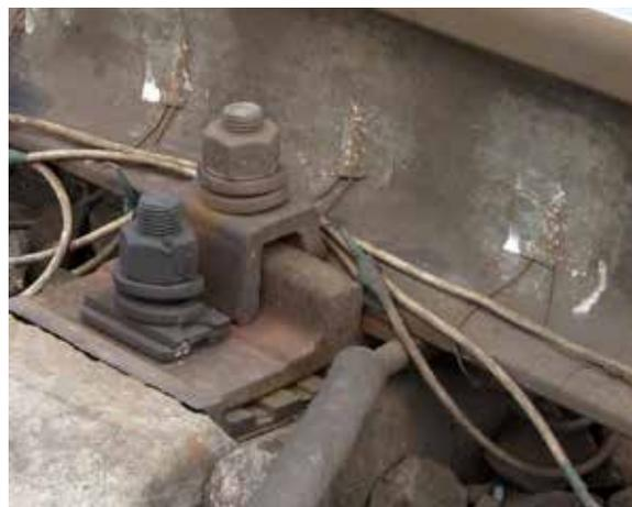
Рис. 4. Система ДДК. Датчики (прикреплены к шейке рельсов)
