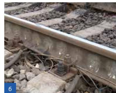
Рис. 5а) Система СКВДН – контрольный участок на перегоне; 5б) Датчик СКВДН (между рельсом и подкладкой)
