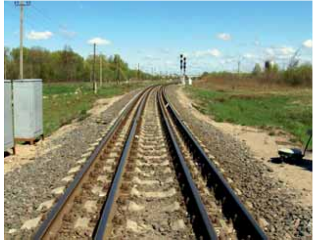
Рис. 1. Совмещенная колея (1520/1435), ст. Дзержинская-Новая, г. Калининград. Источник: http://parovoz.com
