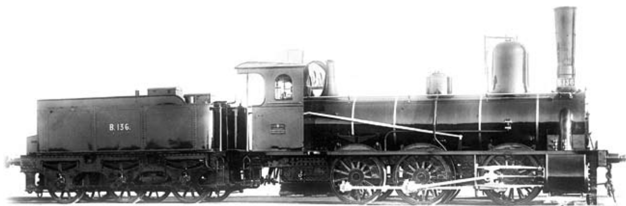
Товарный (грузовой) паровоз, тип 7 — первый паровоз, построенный Коломенским заводом по собственным чертежам
