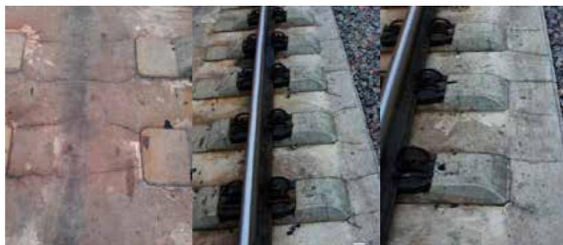
Рис. 2. Трещины в несущей плите безбалластной конструкции RHEDA 2000
