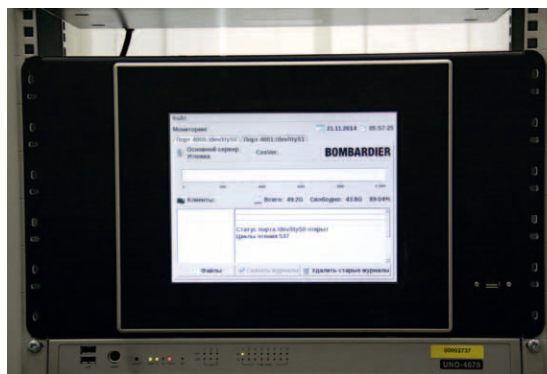
Рис. 3. CyberSafeMon, вмонтированный в шкаф
