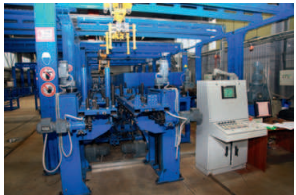
Рис. 5. Внешний вид высокомеханизированного цеха по ремонту деталей «Рама боковая» и «Балка наддрессорная»
